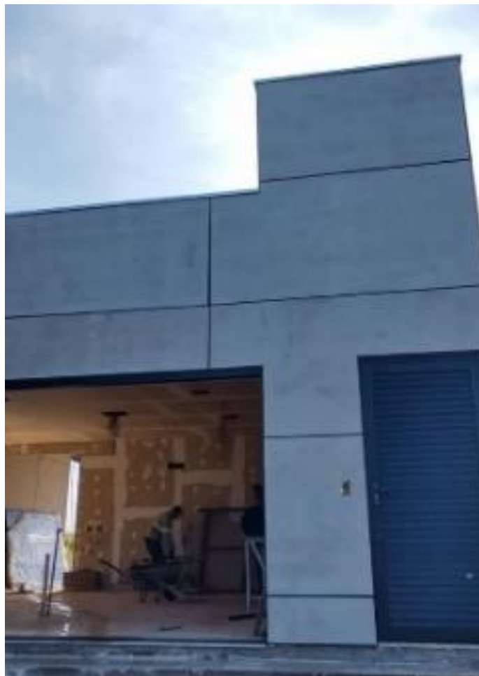
Figura 8: Fechamento em placa cimentícia
