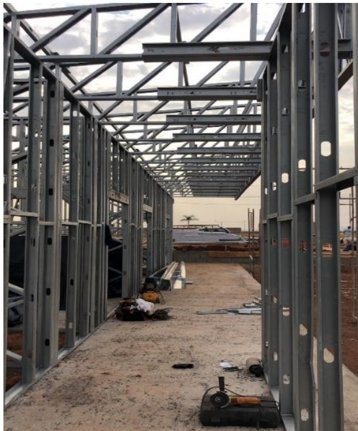
Figura 7: Estrutura em Steel frame sendo montada
