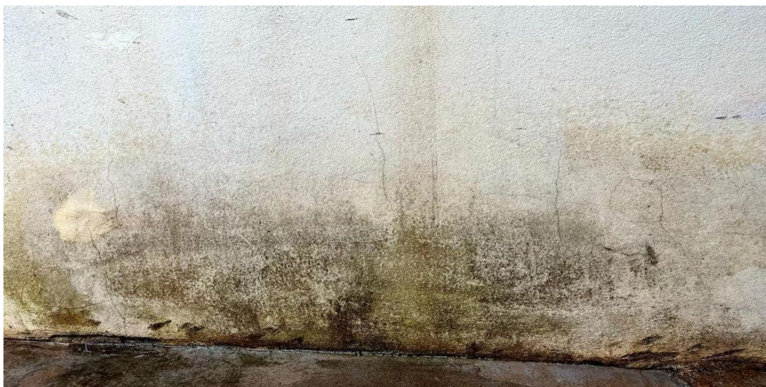
Figura 4: Manifestação patológica devido à capilaridade.
