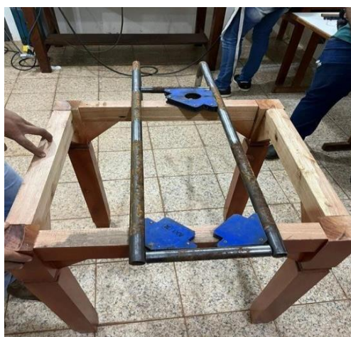
Figura 1 – Montagem da estrutura
