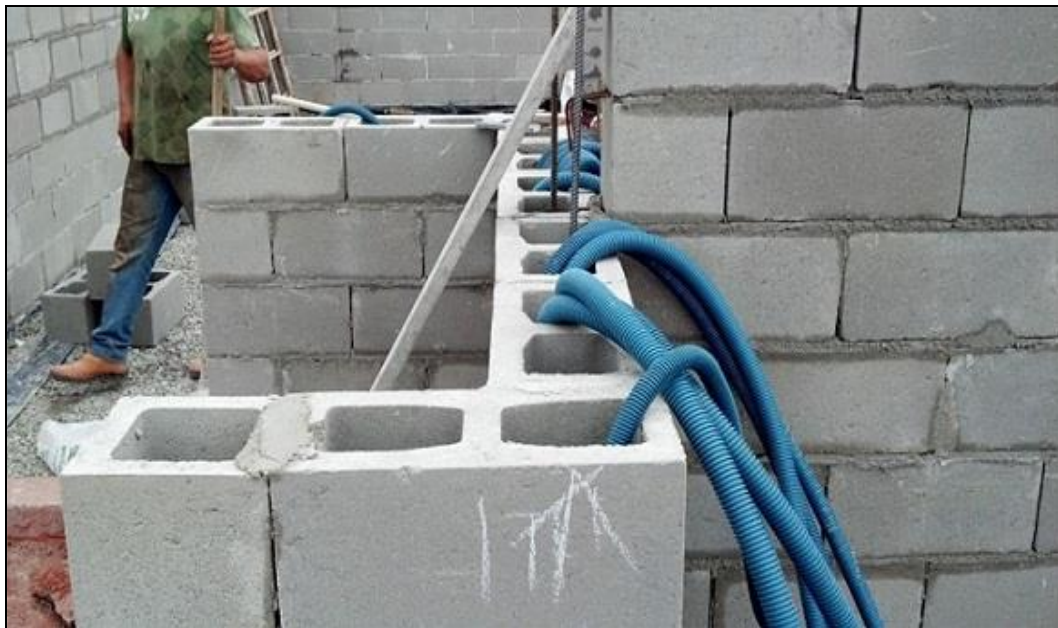
Figura 6: Execução de Alvenaria Estrutural
