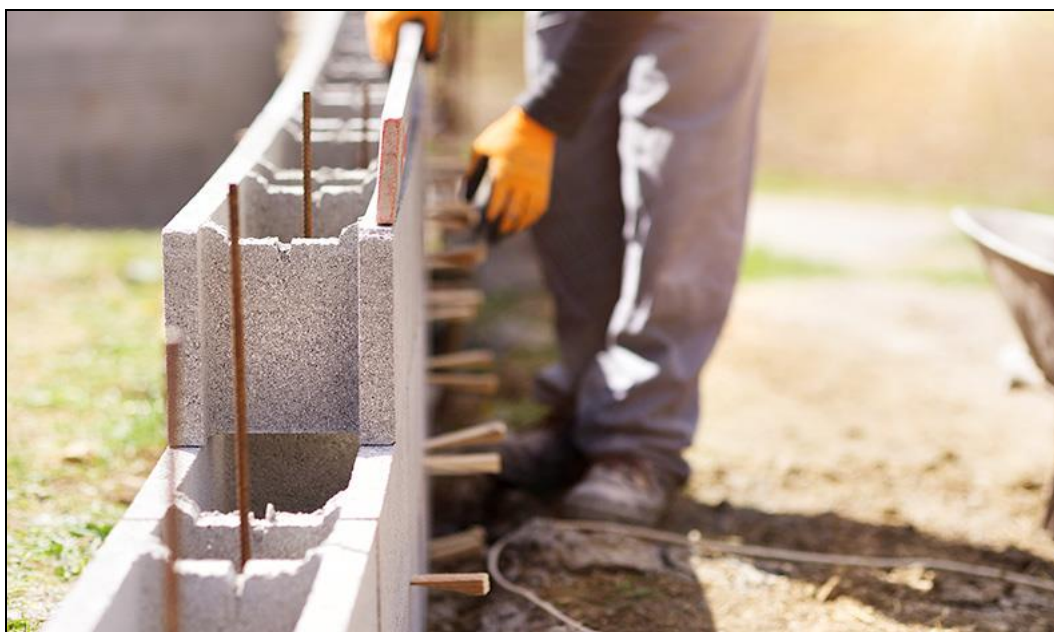
Figura 9: Alvenaria estrutural saindo do solo
