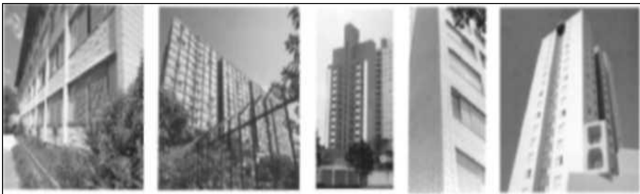
Figura 3: Edifícios precursores da alvenaria estrutural no Brasil
