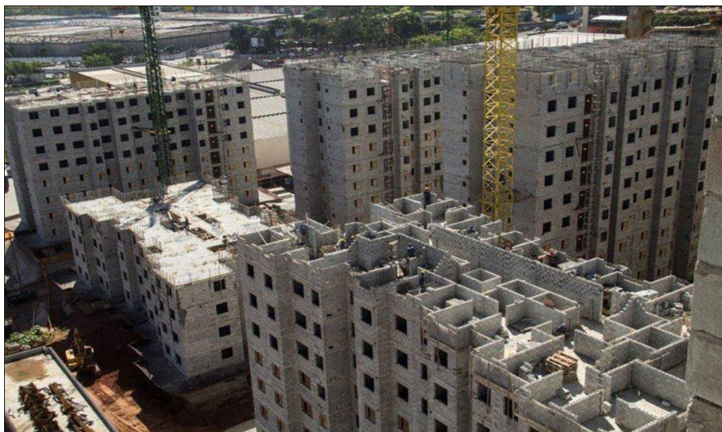
Figura 10: Prédios em alvenaria estrutural
