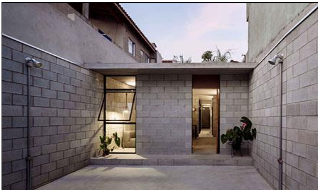
Figura 5: Alvenaria em blocos de concreto
