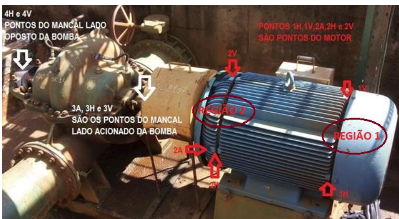
Figura 6: Pontos de coletas dos dados no motor e bomba
