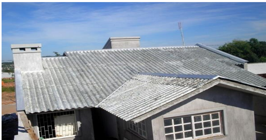
Figura 3 - Residência com telhas de Tetra Pak
