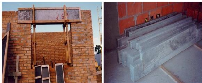
Figura 8 – Redução do número de passos na construção da alvenaria
