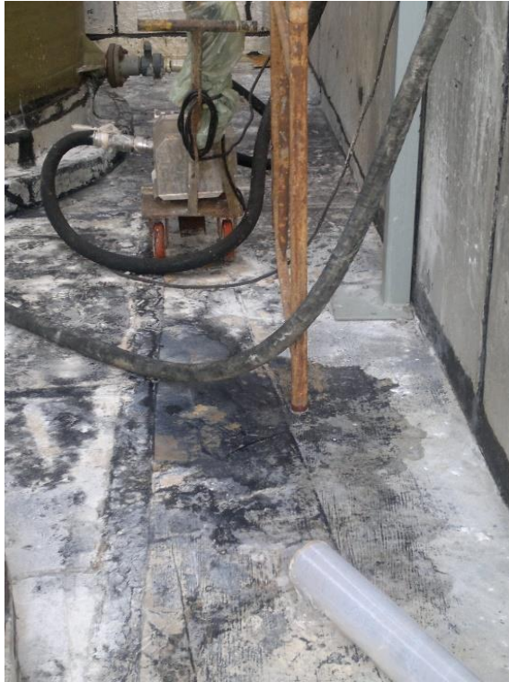
Figura 8 - Perfuração de manta asfáltica.
