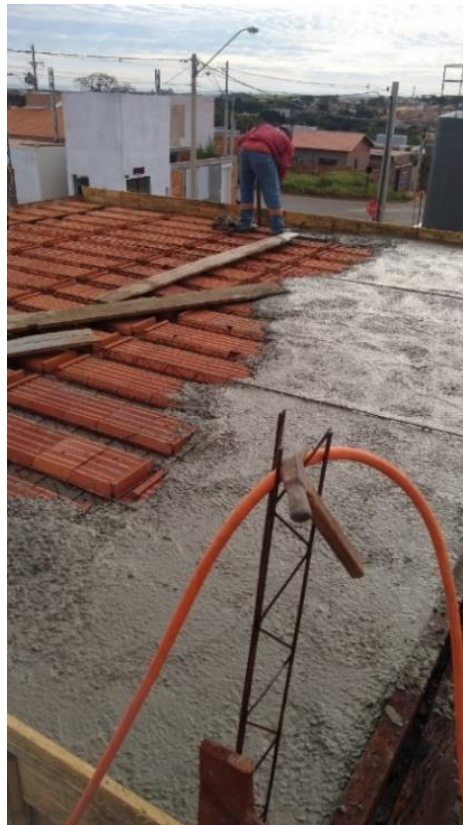
Figura 4 - Reconstrução da laje e concretagem.
