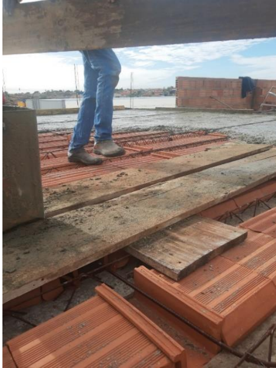
Figura 3 - Reconstrução da laje e concretagem.
