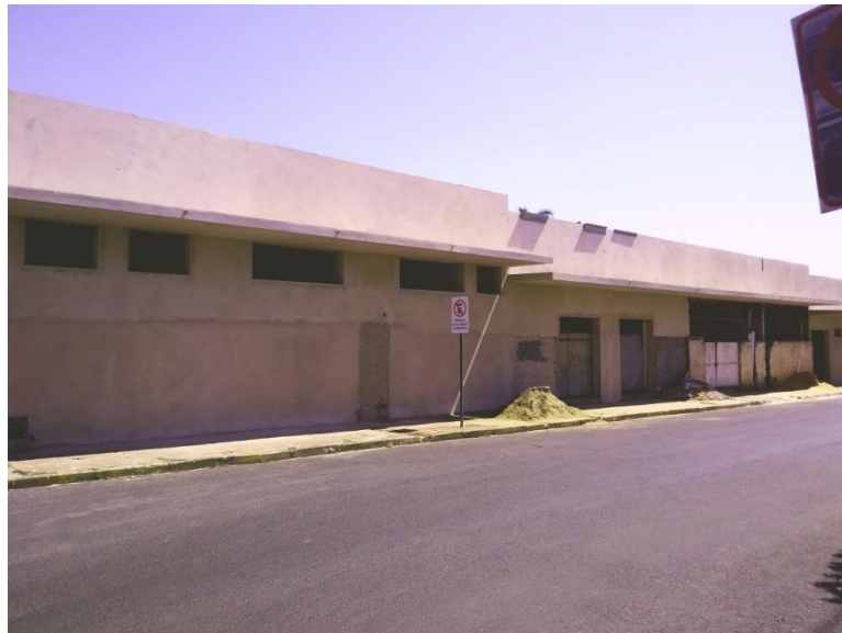
Figura 8 Fachada da Obra B.
