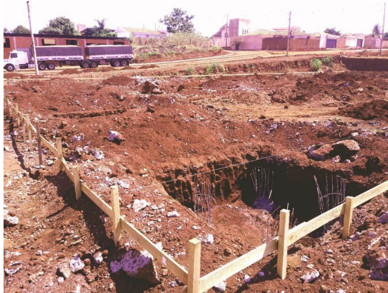
Figura 11 Fundação da Obra E.
