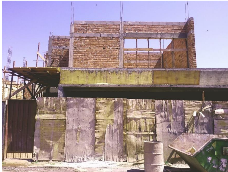
Figura 7 Fachada da obra A.
