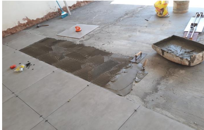
Figura 2 – Aplicação da argamassa.
