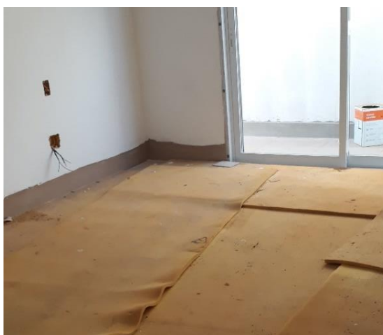
Figura 7 – Proteção da superfície.
