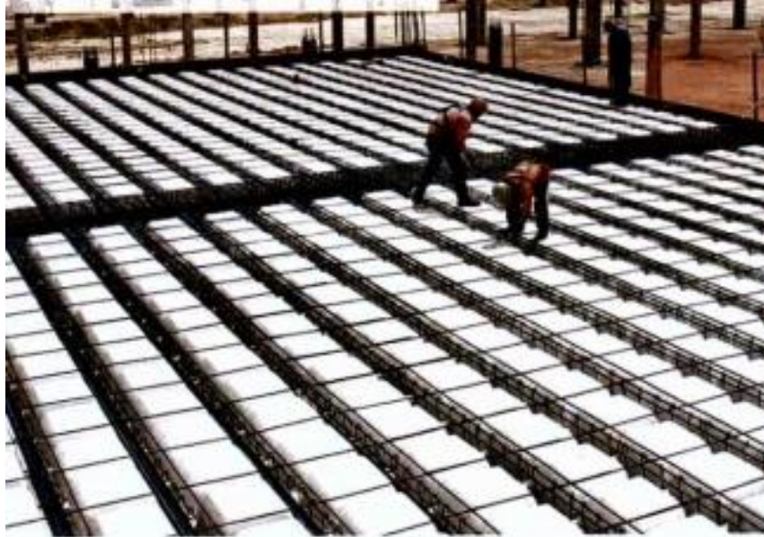
Figura 3 - Uso do plástico em canteiros de obras
